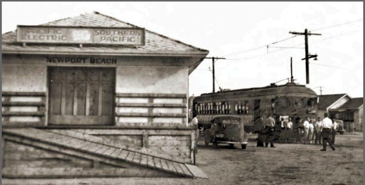
Estación de los ferrocarriles Pacific Electric Railway y Southern Pacific Railroad, Newport Beach, años 1930s.
